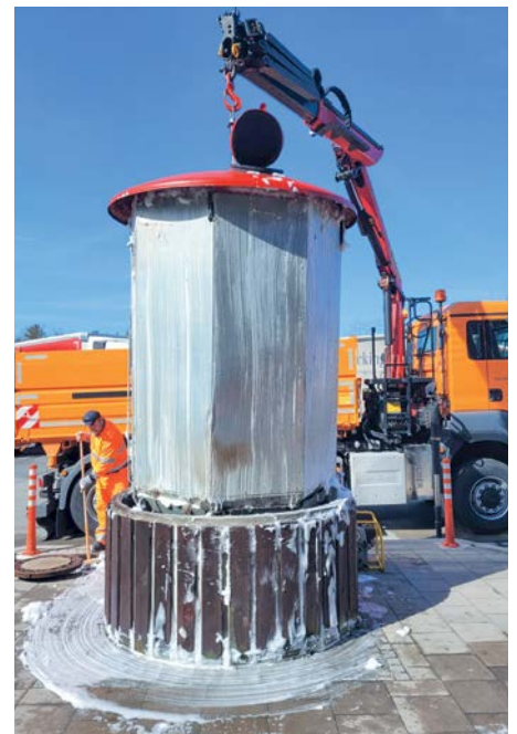
Brand eines Muellcontainers auf einem A9-Rastplatz
